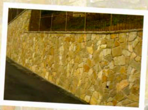
Rivestimento muro con beole fini 3-6
