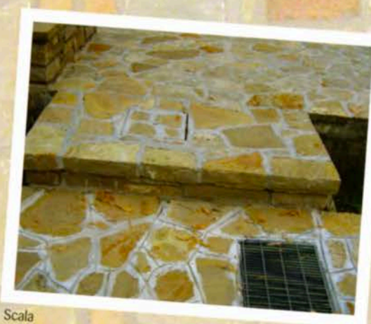
Rivestimento muro con beole fini 3-6 in fase di realizzazione
