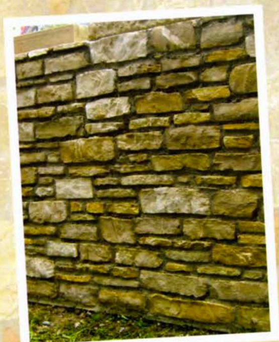
Muro fugato
