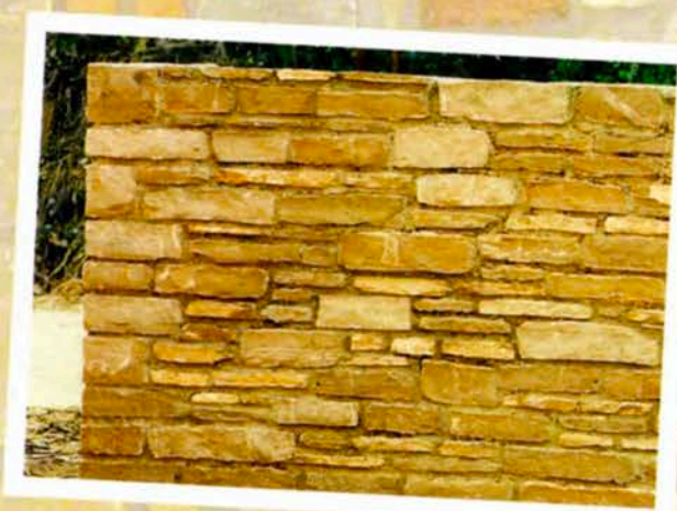
Muro fugato
