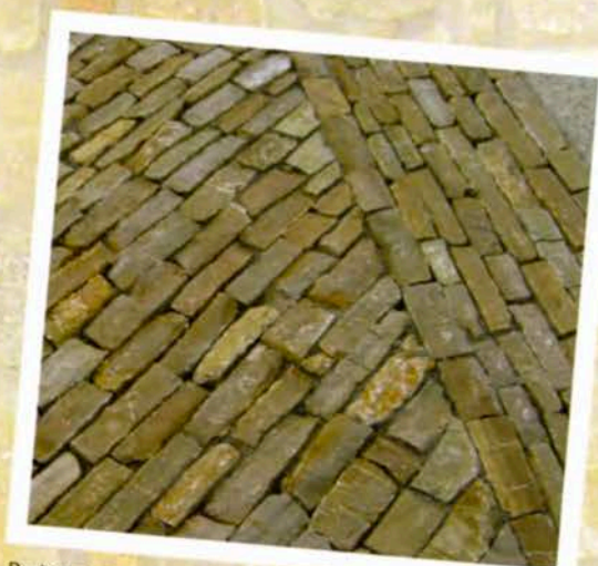
Pavimento secco - semisecco
