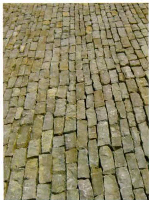
Pavimentazione con Pietrame Tranciato Piccolo
